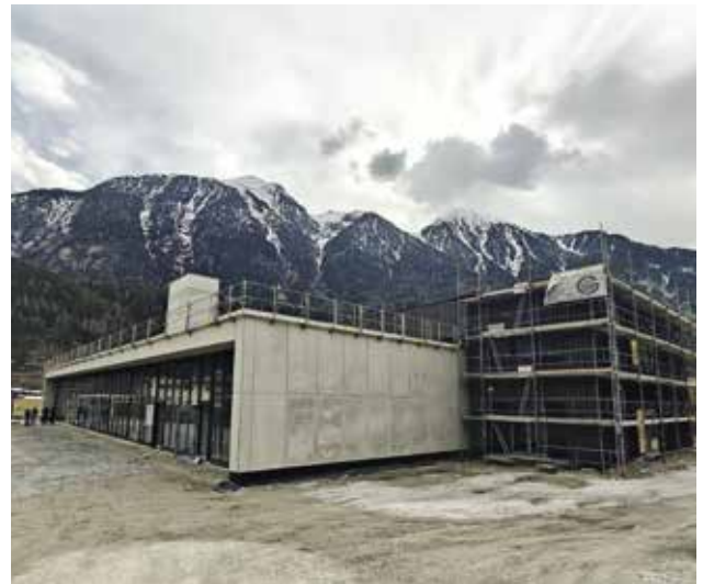
Einsatzzentrum kurz vor Fertigstellung
