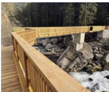
Fertigstellung der neuen Wellerbrücke in Oetz
